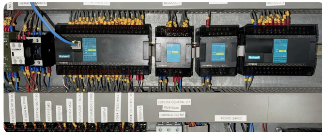
CLP Haiwell T60S0P-e com módulos de expansão
